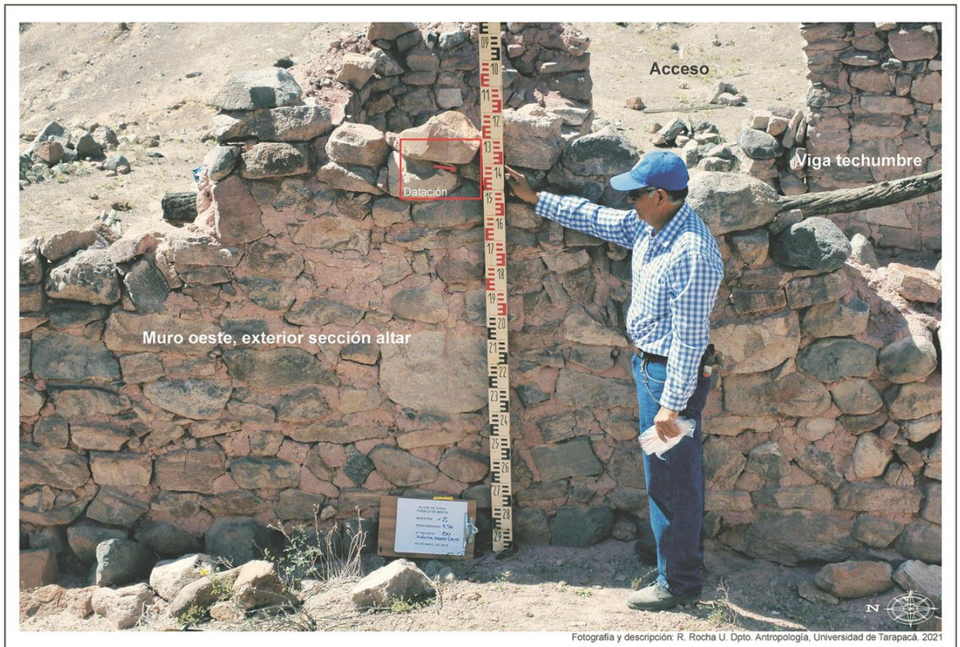
Figura 7. Muro exterior de la iglesia, sector oeste, hecho con argamasa de barro y fibra vegetal. Toma de muestra para datación por  $^{14}\text{C}$  (tabla 1). Fuente: Museo Arqueológico San Miguel de Azapa. En la foto: José Linares (†), trabajador del museo.
