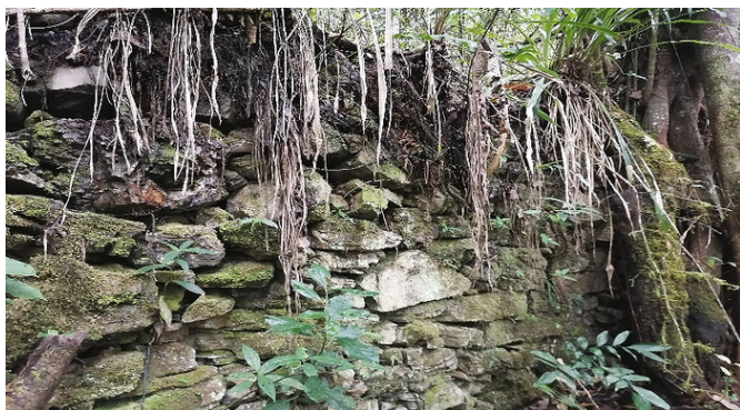
Figura 18. Terraza agrícola con muros altos. Se observa abundante vegetación que cubre las paredes de los muros.
