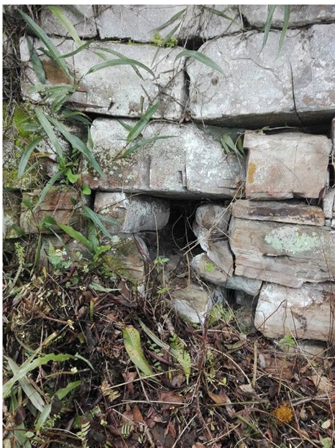
Figura 19. Terraza agrícola con muros altos contruidos con piedra caliza, en buen estado de conservación.
