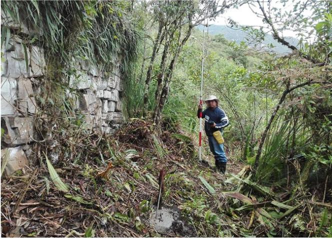
Figura 3. Proceso de levantamiento geodésico con el método RTK.
