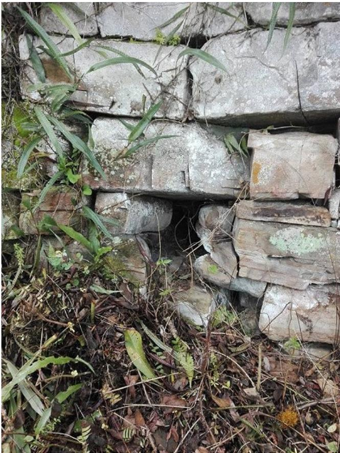
Figura 19. Terraza agrícola con muros altos construidos con piedra caliza, en buen estado de conservación.
