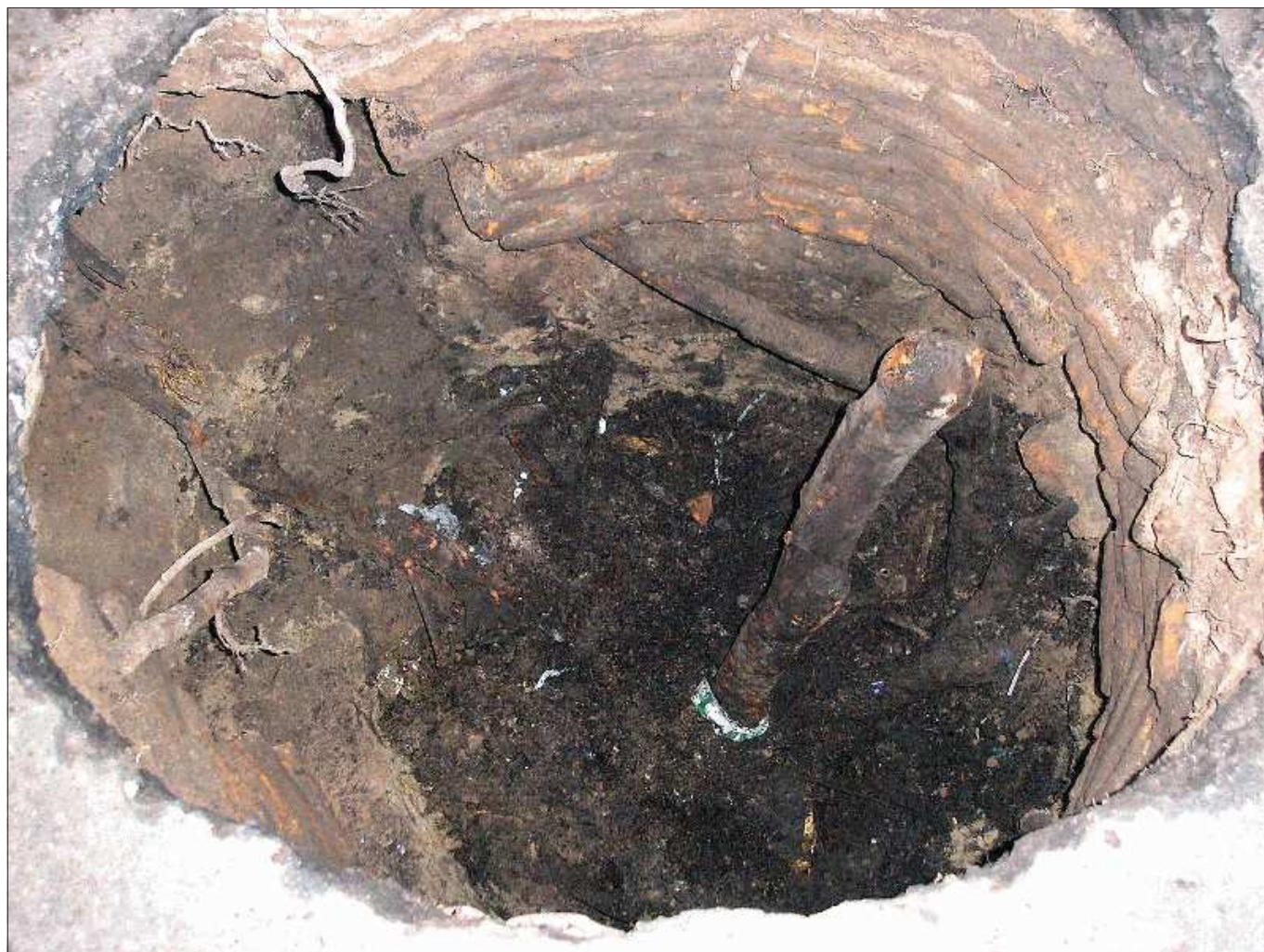
Fig. 7. Vista interna del pozo una vez retirado el relleno moderno y al inicio del sedimento antiguo; nótese el sitio en que estuvo el desagüe, ahora destruido.
