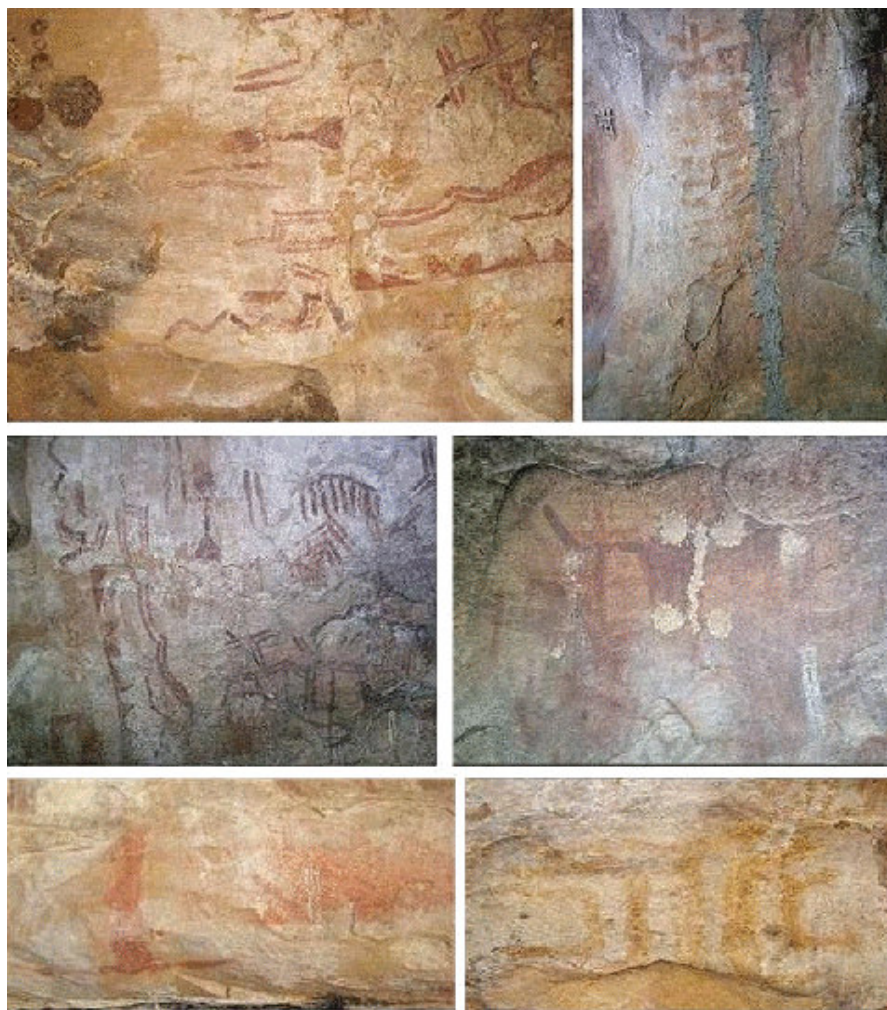
Figura 10. Detalhes de problemas de conservação do sítio Letreiro dos Tanques I.
