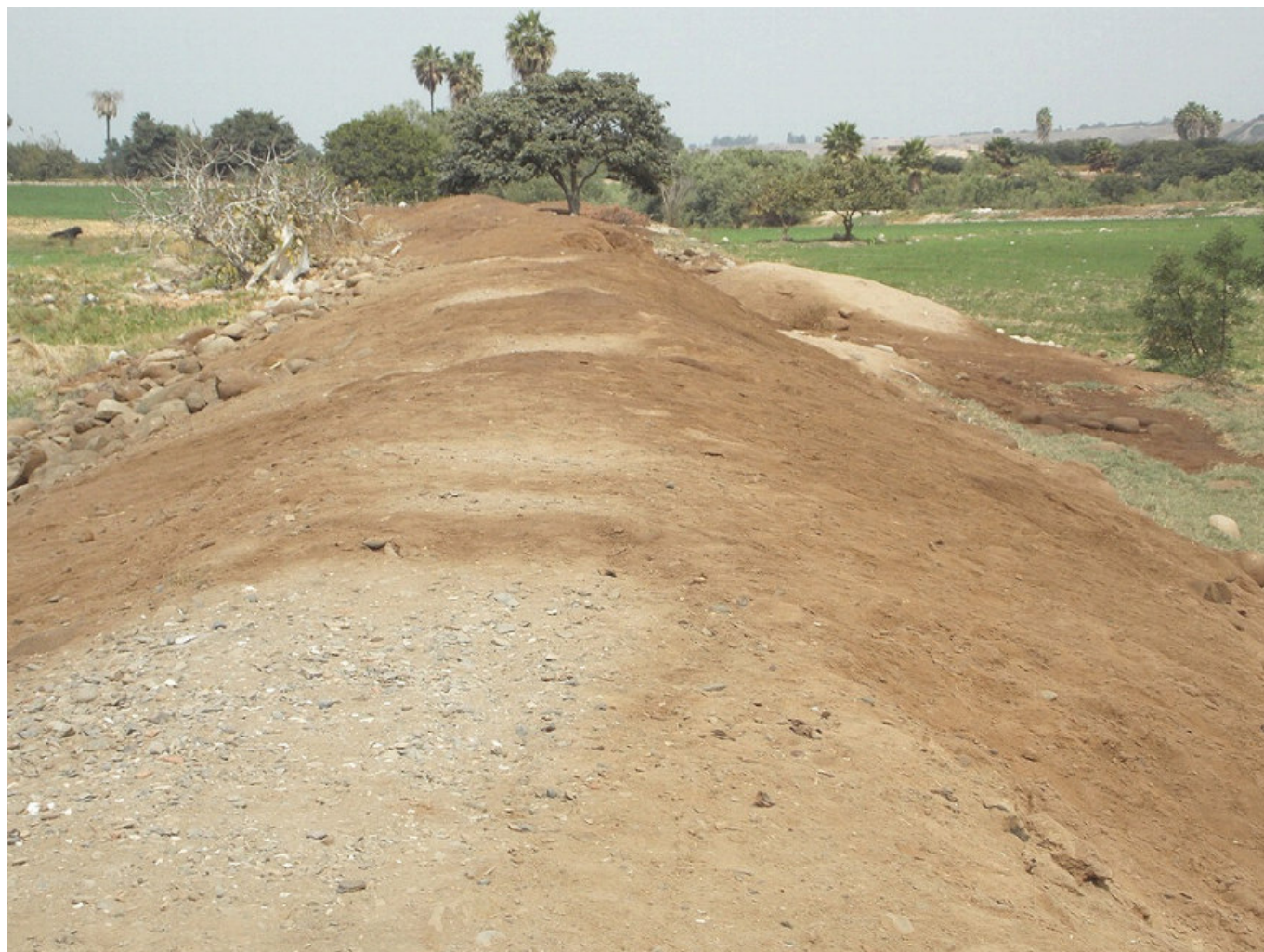
Figura 13. Aspecto general del principal muro del lado oeste de Tambo Viejo.
