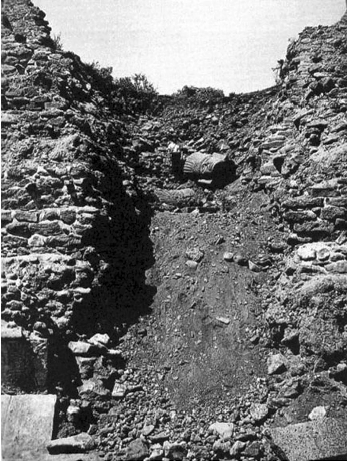
Figura 3. Foto de las excavaciones tempranas de Acosta mostrando evidencias de las primeras intervenciones durante la época azteca en el centro ceremonial de Tula, como esta decapitación y “entierro” de una escultura Atlante de la era tolteca. Foto cortesía de: www.latinamericanstudies.org/toltecs/
