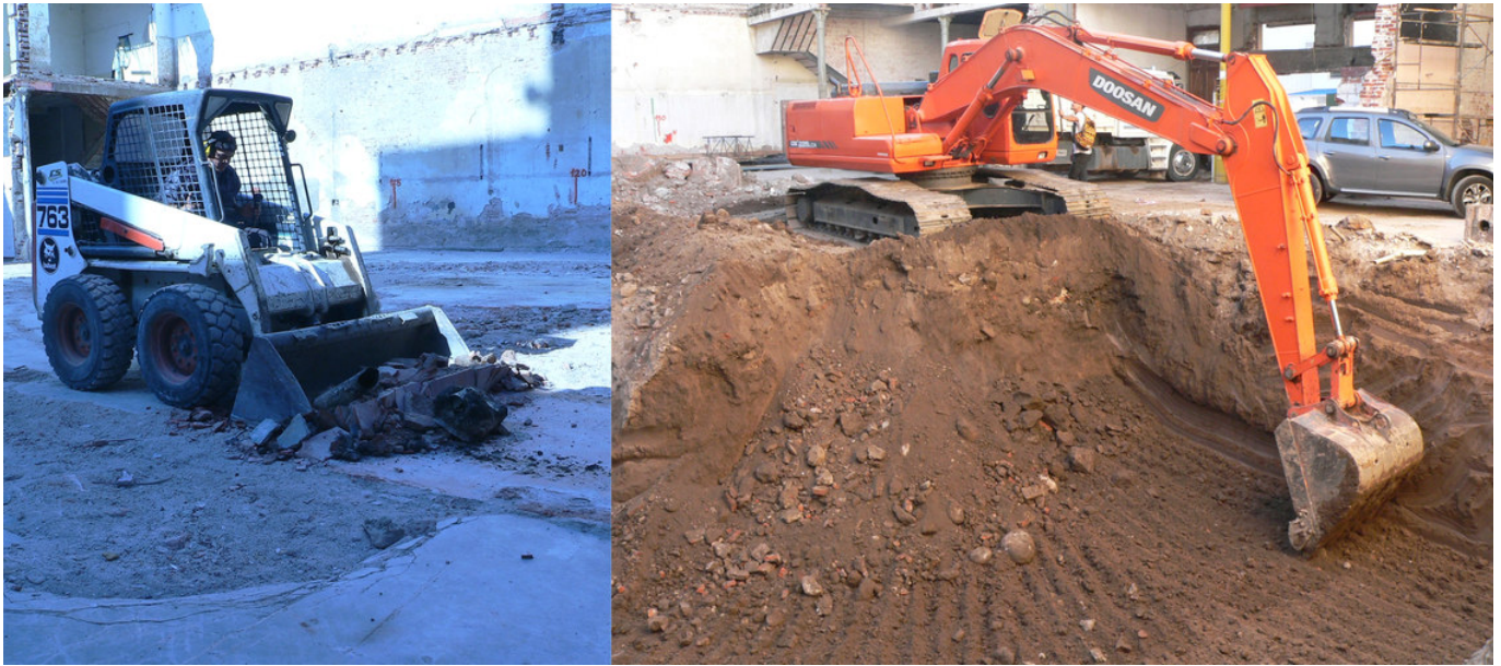
Figura 3. La fotografía de la izquierda muestra la extracción mecánica con cargadora Bobcat de una unidad estratigráfica de manera individual. En la fotografía de la derecha se exhibe la excavación con retroexcavadora.
