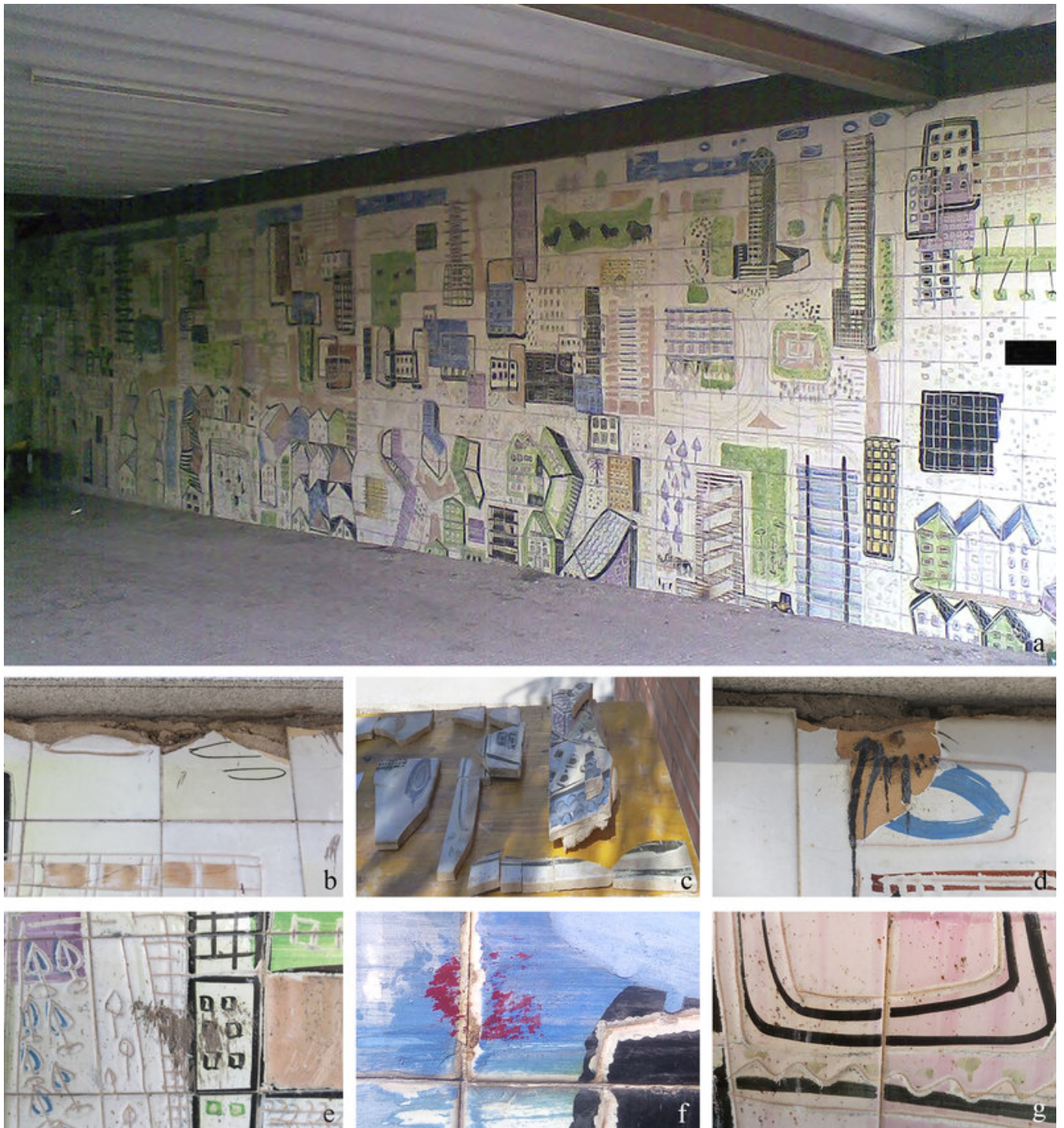
Figura 5. a) Estado del mural tras la remodelación del año 1972: cubierta de fibrocemento y solado de losetas de cemento con elevación de nivel respecto al original (fuente: Gago y García 2004); b) pérdidas de fragmentos de azulejos en la línea superior del mural; c) fragmentos recuperados y recomposición de piezas; d) soldadura metálica sobre bizcocho y vidriado; e) restos de cemento; f) repintes acrílicos sobre retoques cromáticos; g) punteaduras de soldadura metálica incrustadas en el vidriado de la cerámica. Fuente (b-g): Laura de la Colina y Marta Plaza.
