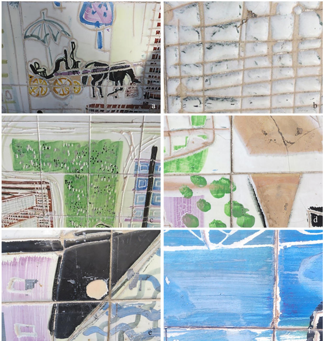
Figura 3. a) Detalles de esgrafiado inciso contorneando las figuras; b) esgrafiado creando texturizado de fondos; c) esgrafiado punteado; d) esgrafiado barrido y retoques con punteado verde sobre esmalte; e) retoques azules en forma de líneas serpenteantes sobre otras líneas grises esmaltadas; f) pinceladas azules con textura aplicadas sobre fondo del mismo color esmaltado. Fuente: Laura de la Colina y Marta Plaza.
