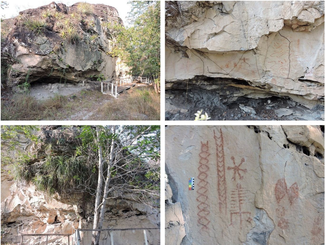
Figura 5. Detalhes de problemas de degradação que atingem a Pedra da Inscrição: deslocamentos do arenito-suporte, plantas presas ao suporte rochoso, ninhos e galerias de cupins, manchas geradas por umidade e proliferação de microrganismos, passarela instalada de forma inadequada e construída com materiais não recomendados, pichações.
