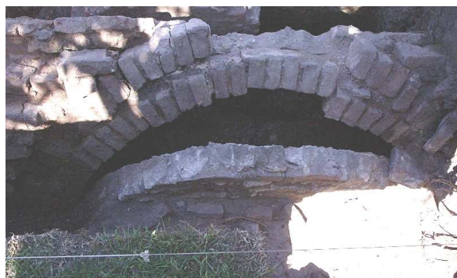
Figura 12. Uno de los arcos que formaban las paredes tras su excavación; eran arquerías a las que se les agregó como cierre una pared de ladrillos cortados.
