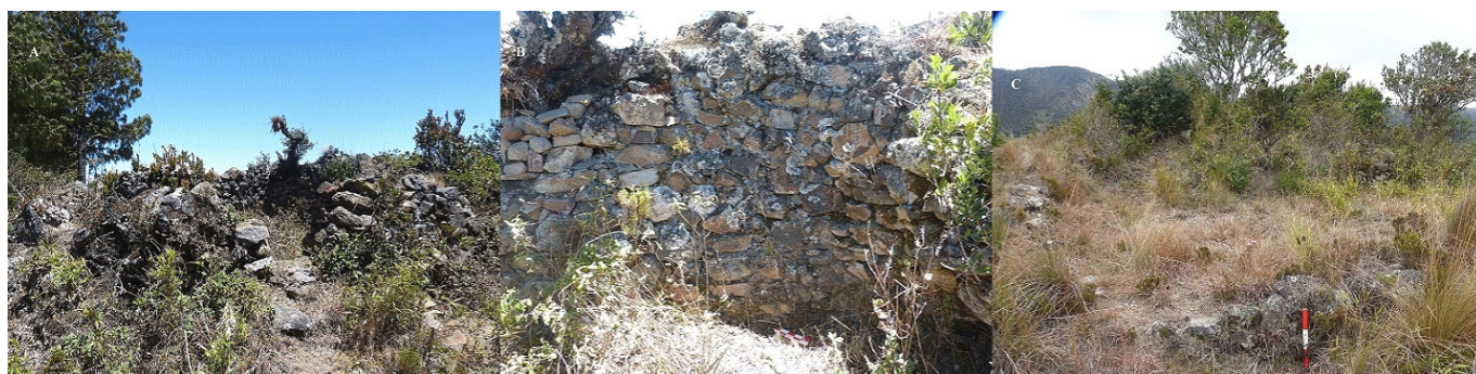
Figura 5. A) Estructura E9. B) Detalle del muro en E9. C) Estructura E7 rectangular.
