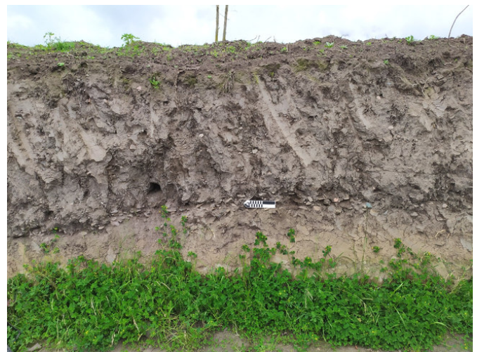
Figura 2. Perfil de la carretera junto a Puculpala afectando al sitio arqueológico.
